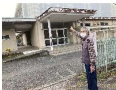
南高麗小外壁の塗装 (加治)
