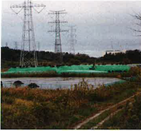
帰還困難区域での汚染土の仮置き場
