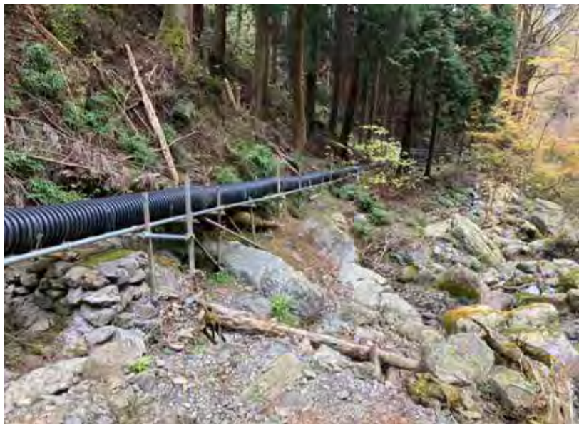
取水口から発電機へと送水するパイプ
