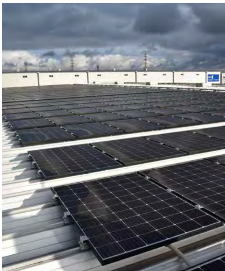
川島工場屋上にある合計1188枚の太陽光パネル
