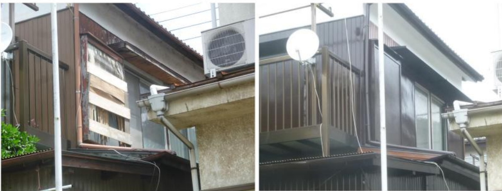
施工前の状態
