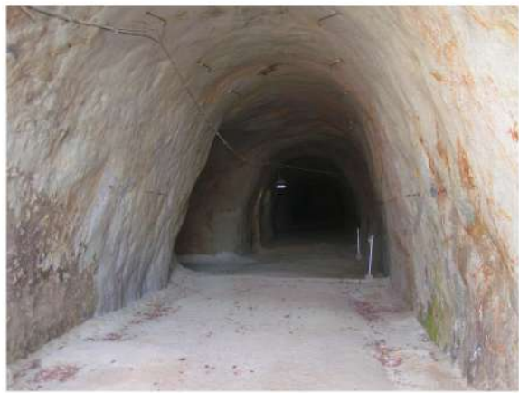
見通せないほど大規模な「突貫」工事
