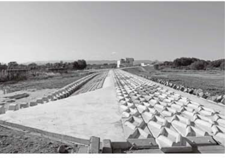
修復した堤防
