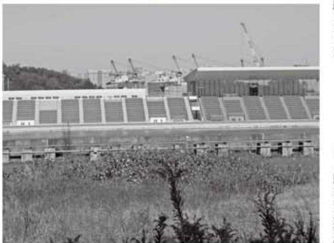
ゴールの観客席も屋根は半分で未完成
