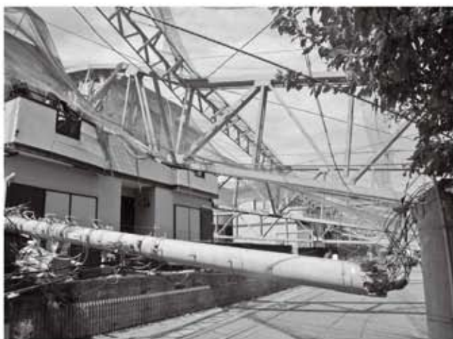
ゴルフ練習場の支柱が自宅へ
