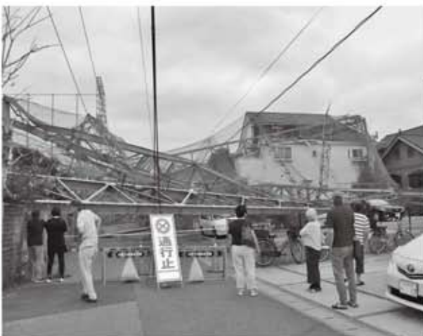
ゴルフ練習場の倒壊で生活道も通行止
