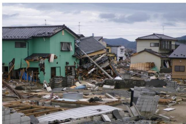
現地では、広範な壊滅地域は自衛隊、道路にあふれたガレキ・廃棄物・自動車・ヘドロの土壌は各自治体の行政が担っていました。埼玉土建は、建設系のボランティアの仕事として、建物が直せば使える状態で住人がいて、支援センターに要請があった建物に行きました。作業内容は、床板を剥がして、床下のヘドロ撤去、海水がしみた断熱材・ボードの撤去、壊れた間仕切りの撤去、室内の流入物の撤去、壊れかけたブロック塀の解体などです。壊している箇所と内容を、住人と確認しながらの作業となります。しかし、まだ電気が通っていない家、水が使えない家はまだありました。朝食は自前が原則でしたが、コ
