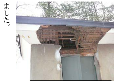
地震による被害。土壁が崩落
